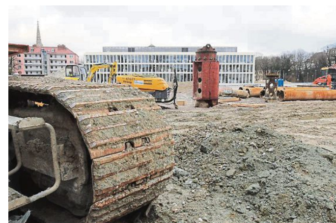
Baggern in der Au: An vielen Stellen in der Stadt wird gebaut, hier auf dem ehemaligen Paulaner-Areal.
